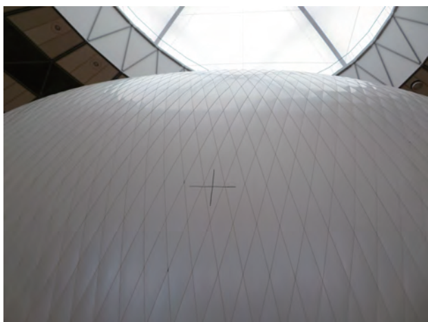
図 18: パネル中央部。フィルムの余剰なし。
