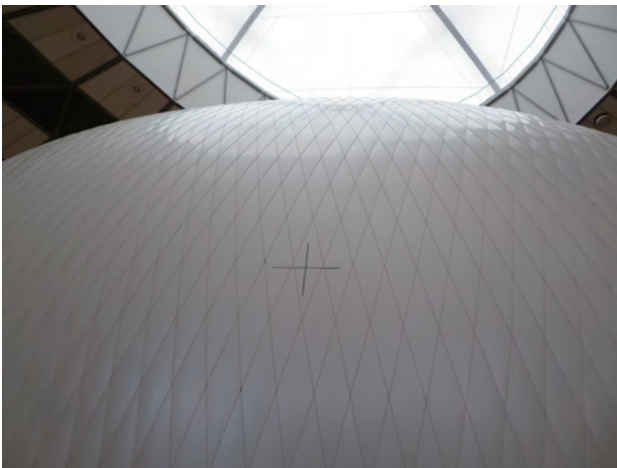
図 18: パネル中央部。フィルムの余剰なし。
