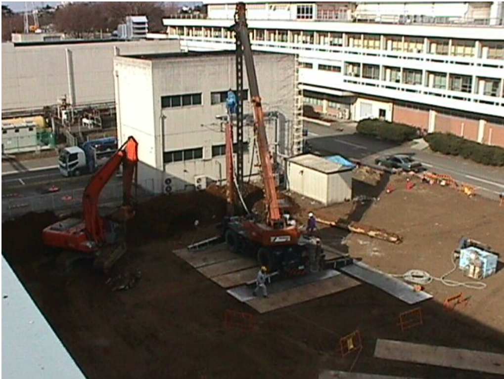
図 4-6 原動機 5 号館北側整地完了(1999/1/8)
