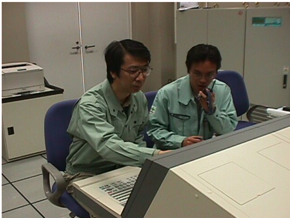
図 4-15 超音速エンジン試験施設調整運転 (2000/10/28)
