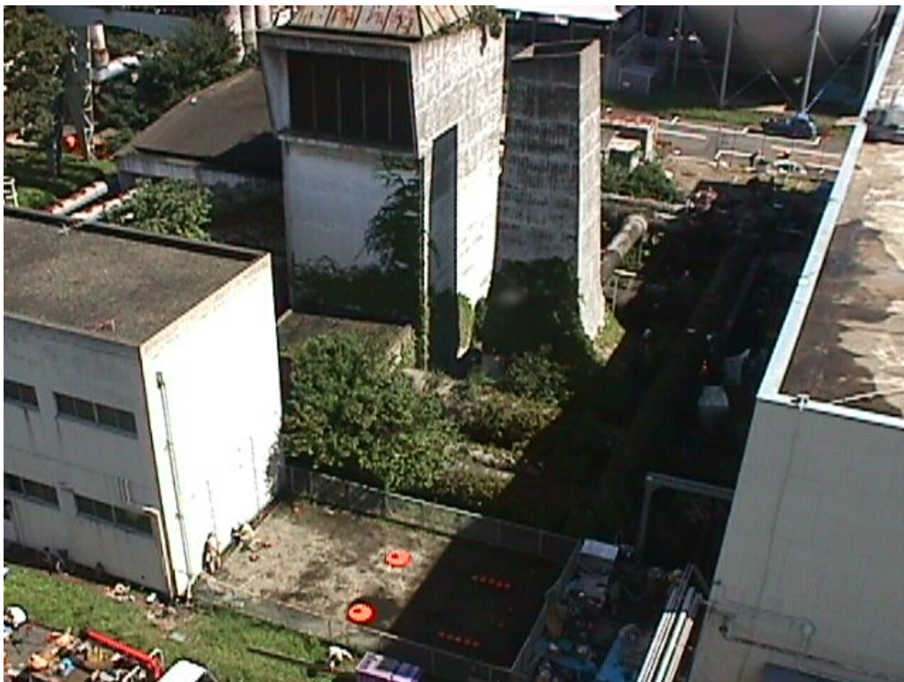
図 4-2 原動機 5 号館北側状況(1998/10/2)
