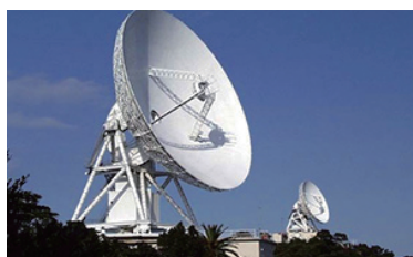
34m アンテナと 20m アンテナ (衛星追尾)
