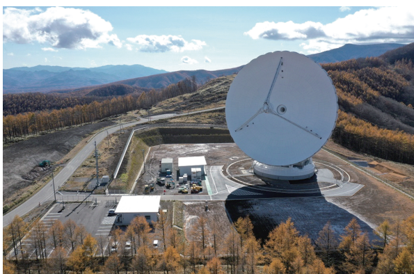
完成した新地上局 (敷地内及び周辺の外構工事後)
