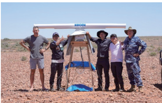
マリンレーダ設置
