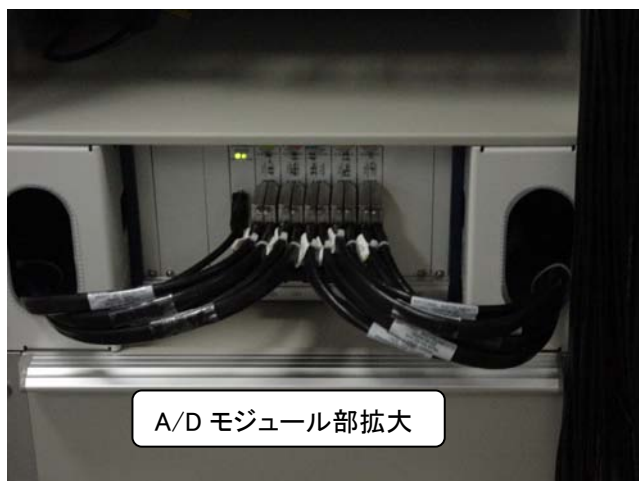
図 5 A/D モジュール部の拡大写真
